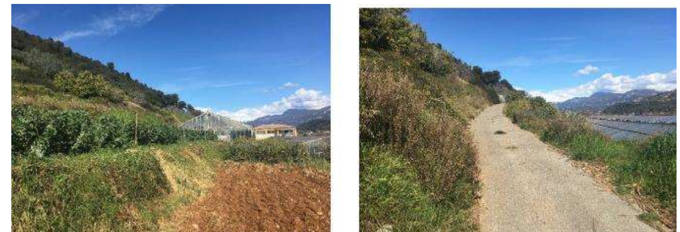
Figure 68 Ruptures de pentes au niveau des cultures en terrasses et chemins
