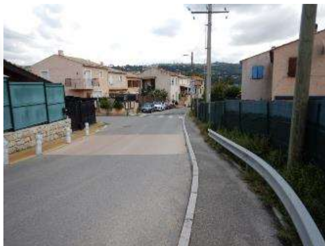
Figure 129 Traversée du hameau de La Baronne (auteur : INGEROP, 2020)
